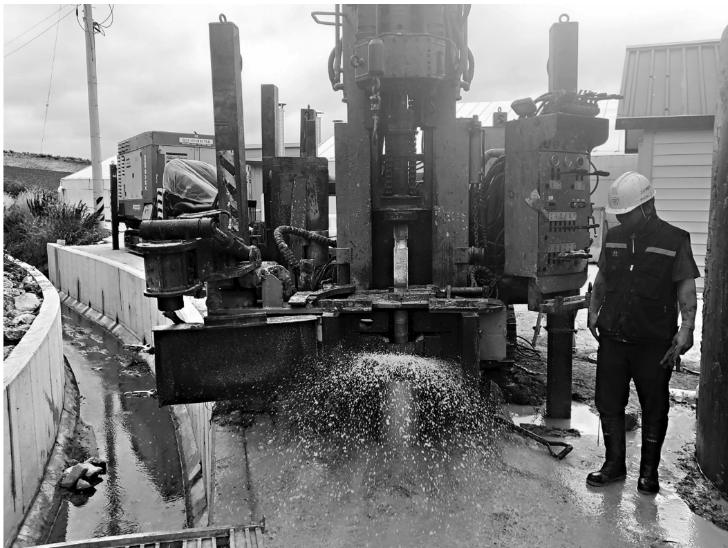
농어촌공사 직원들이 반복되는 수온차로 어려움을 겪는 육상양식 어가가 지하해수를 활용할 수 있도록 지하해수 부존 확인을 위한 시추작업을 하고 있다. /한국농어촌공사 제공
