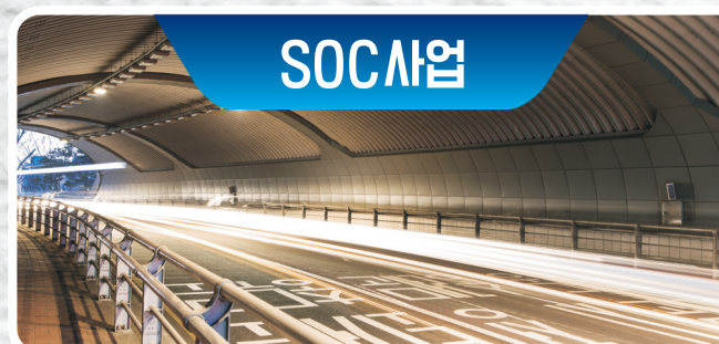
SOC사업 가드레일 / 교량난간 / 터널 방음벽 / 방음벽
