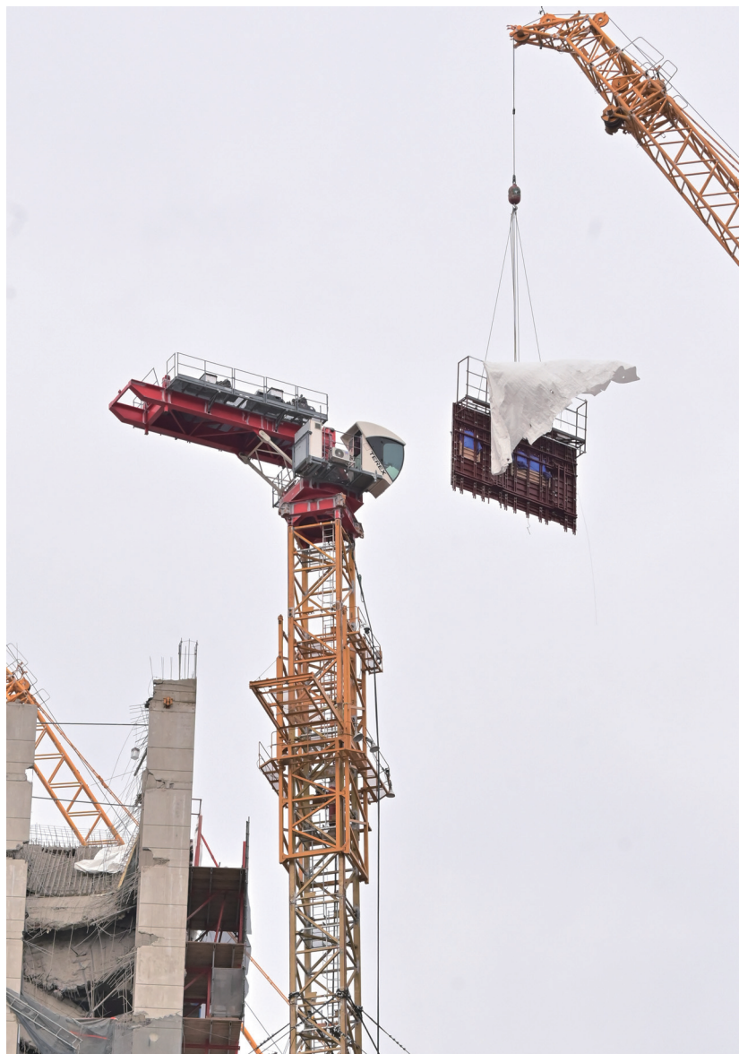
23일 오후 광주시 서구 화정아이파크 붕괴사고 현장에서 안전한 구조작업을 위해 건물 상층부의 거꾸집인 RCS(Rail Climbing System)폼(오른쪽)을 제거하고 있다. /김태규 기자
