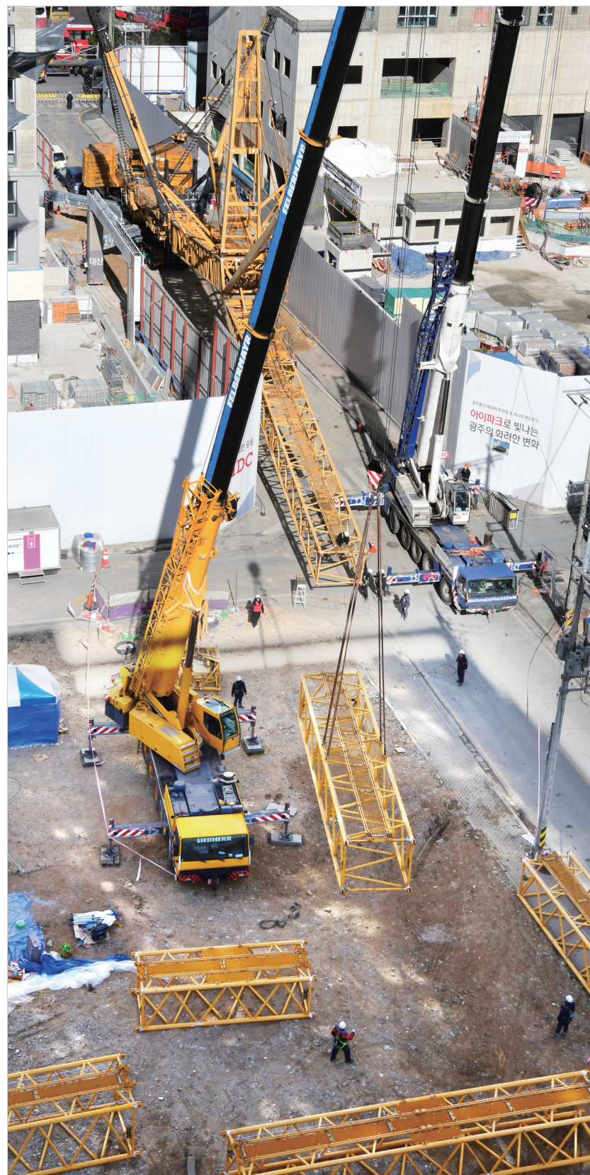
광주시 서구 화정아이파크 신축아파트 붕괴사고 발생 16일 관계자들이 타워크레인 해체 작업에 투입된 크레인 조립 작업을 하고 있다. /김태규 기자
