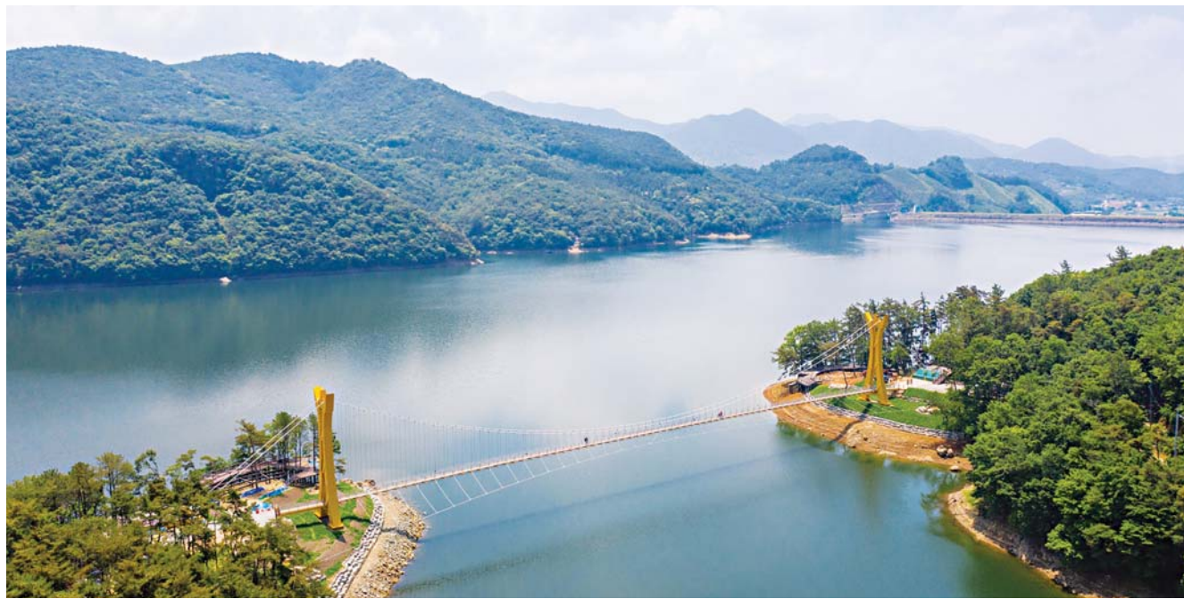
장성군이 올 연말까지 장성호 수변길에 제2출렁다리를 만든다. 사진은 장성호에 설치된 제1출렁다리.
