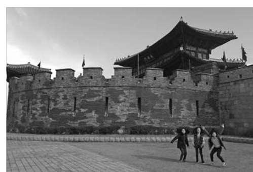
장안문은 한양의 남대문보다 더 큰 규모이며 정조가 황금군복을 입고 자신감을 보이며 들어섰던 문이다.
