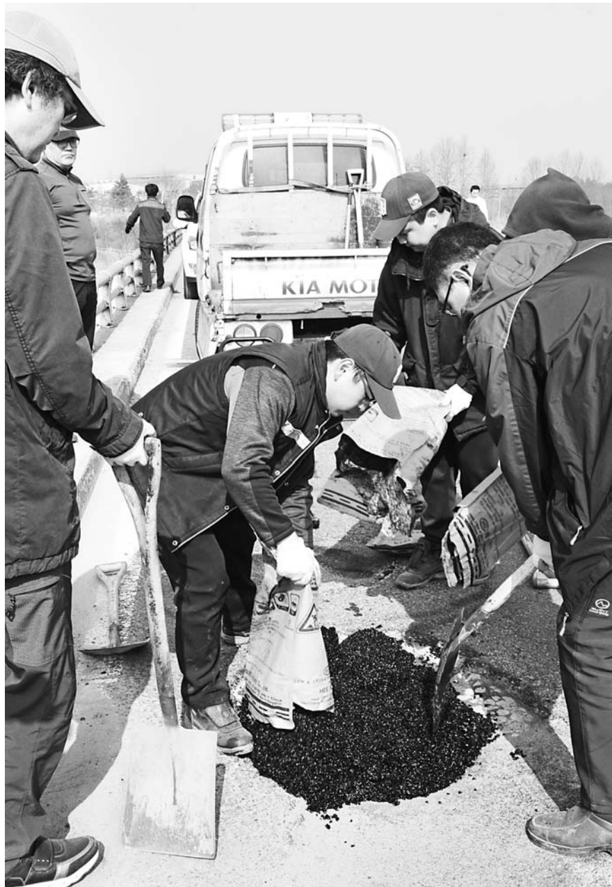
포트홀 긴급보수 12일 오전 광주시 북구 용두교에서 복구청 건설과 긴급도로보수팀 직원들이 포트홀을 긴급보수하고 있다. /김태규 기자
